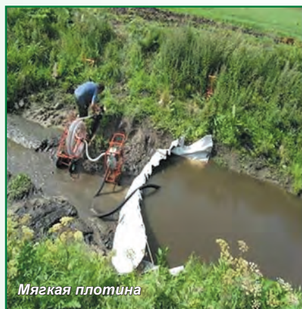
Рисунок 2 – Технологии уходовых работ, включающих оценку состояния и очистку закрытой мелиоративной сети
